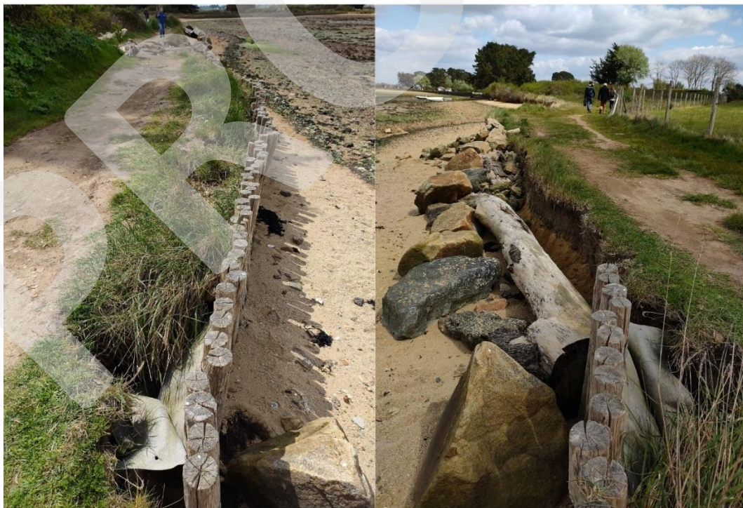
Figure 25 : Expérimentation de défenses contre la mer pour limiter l'érosion de falaises meubles via des pieux en bois
