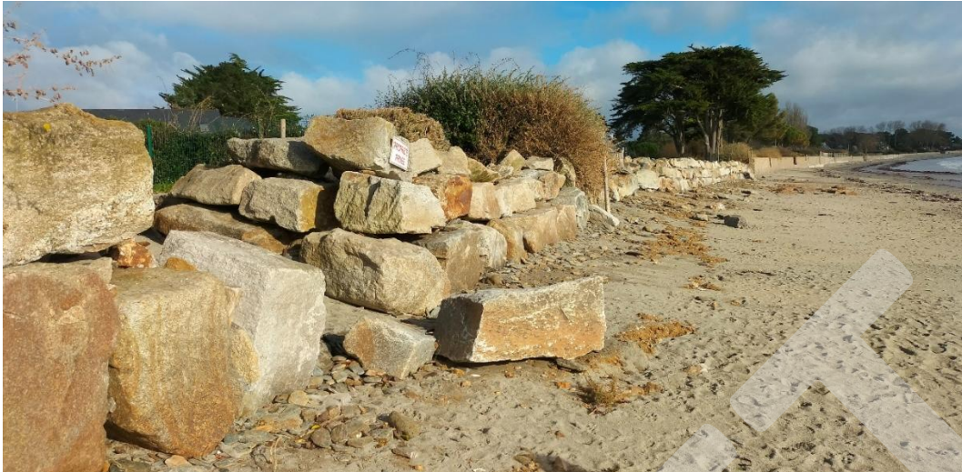
Figure 22 : Enrochements et murs privés à Kerfontaine, Sarzeau
