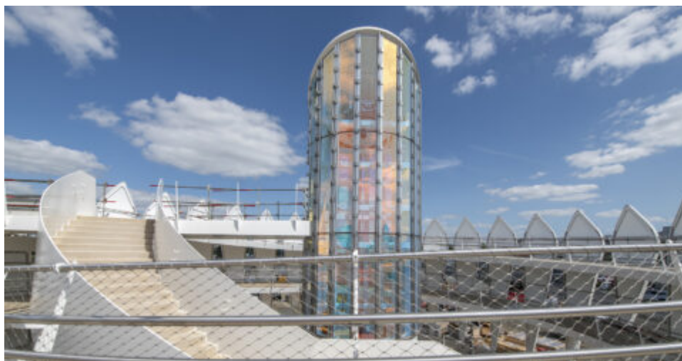
Mobilité/Pôle d'échanges multimodal (PEM) de la gare de Vannes
